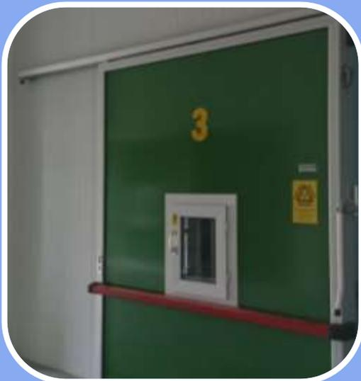
Хранение в контролируемой атмосфере предъявляет особые требования к герметичности камер, дверей, пола.
